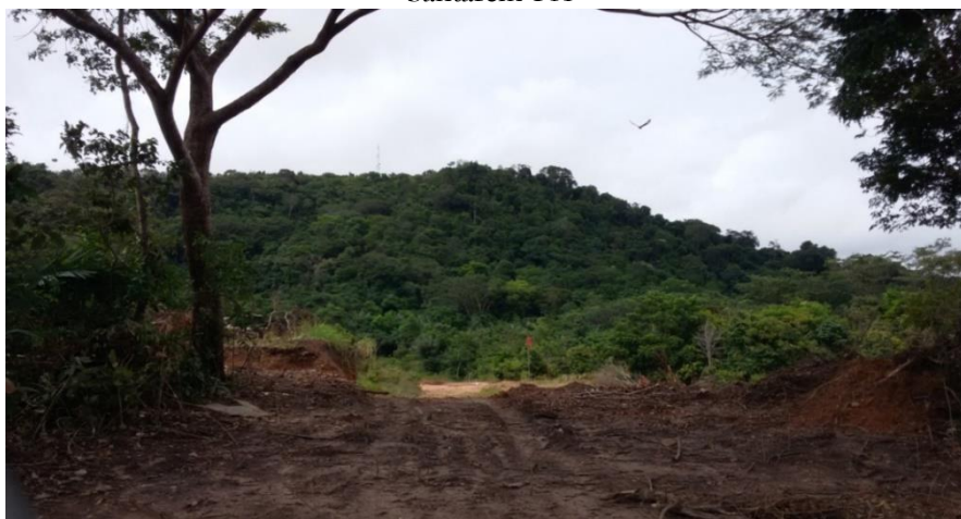
Figura 05. Área de mercado imobiliário em atividades de terraplanagem, bairro Santo André, Santarém-PA
