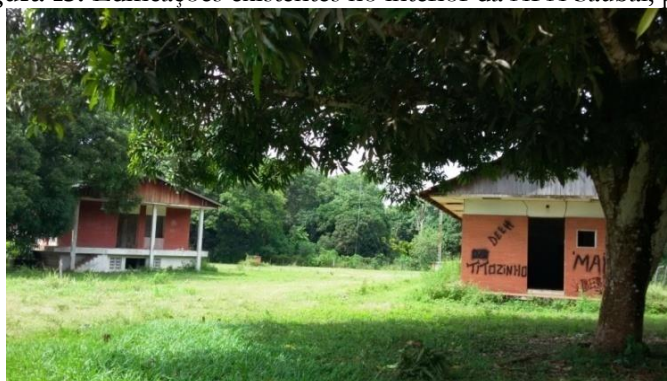
Figura 13. Edificações existentes no interior da APA Saubal, porção norte.
