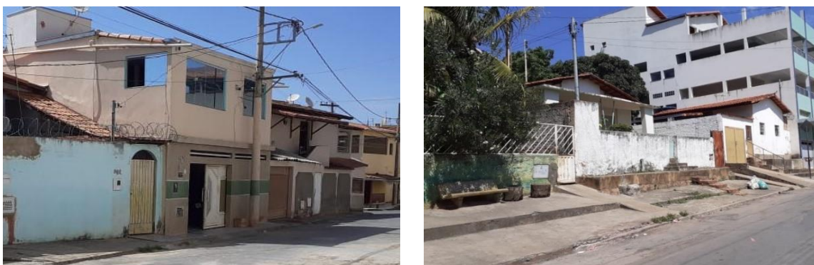
Figuras 03, 04. Calçadas intransitáveis devido a ocupação por mobiliário e obstáculos fixos
