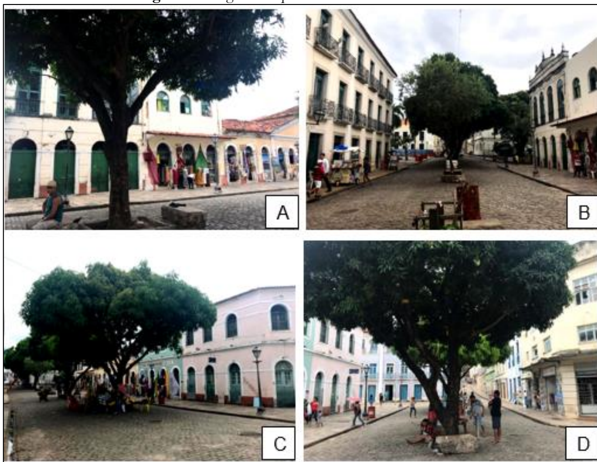
Figura 2. Imagens da quadra 2 – rua da Estrela
