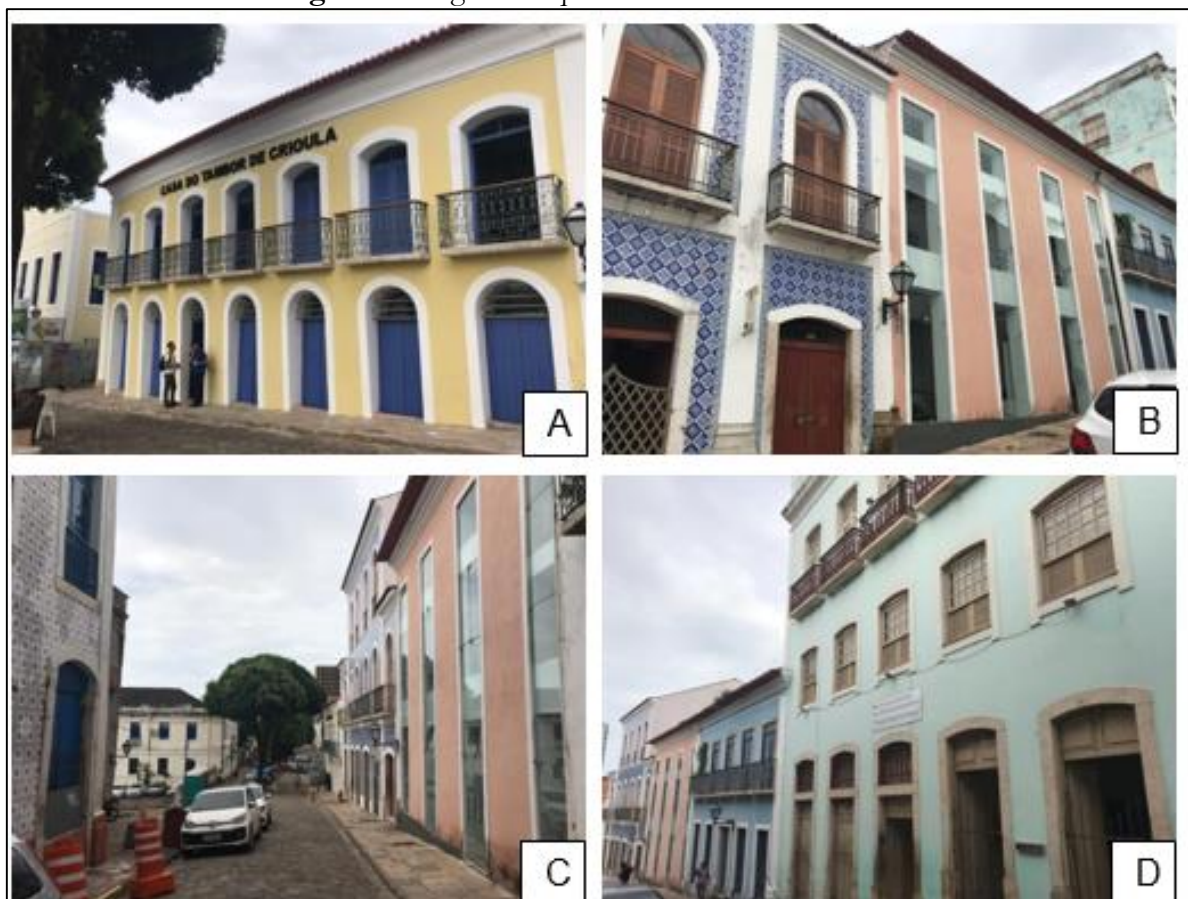
Figura .: Imagens da quadra 1 – rua da Estrela
