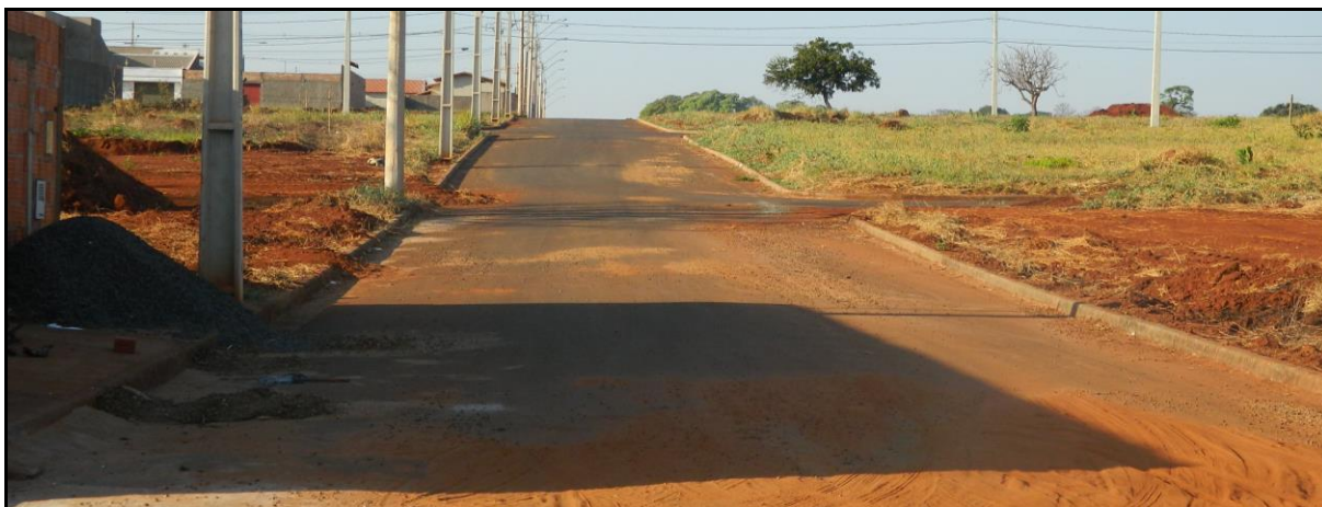
Figura 8. Comprimento de rampa da vertente retilínea que foi esculpida pelo processo de terraplanagem e impermeabilizada. Registro realizado no bairro Jardim Copacabana.
